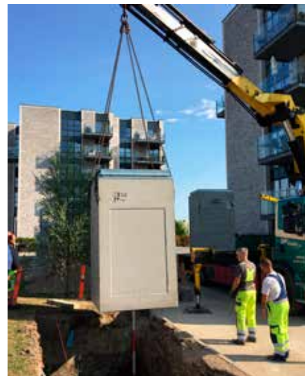
Betoncontaineren placeres i det klargjorte hul.
