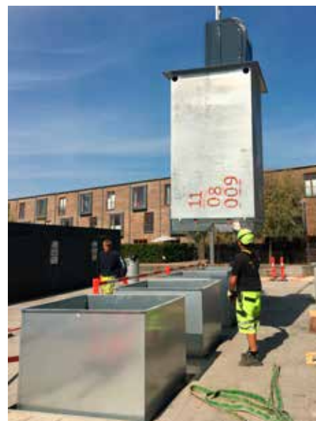
Sikkerhedshegn afspærrer containerhullet ved tømning.
