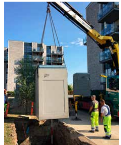
Betoncontaineren placeres i det klargjorte hul.
