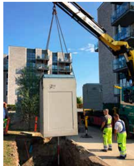
Betoncontaineren placeres i det klargjorte hul.
