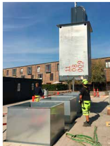
Sikkerhedshegn afspærrer containerhullet ved tømning.
